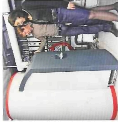
Moderne Ölbrennwertgeräte arbeiten sehr effizient. Dank der ausgefeilten Technik nutzen sie den Energiegehalt des Brennstoffs fast zu 100 Prozent aus. Foto: IWO
