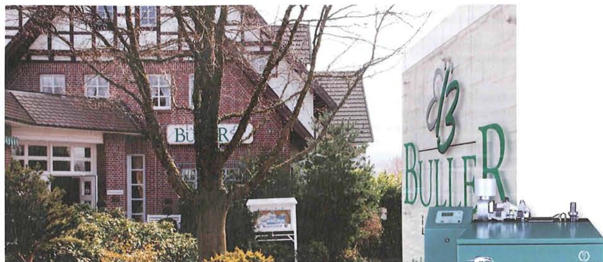
Hoher Wohlfühlfaktor, niedrige Energiekosten: das Landhotel Buller in Hagen am Teutoburger Wald
